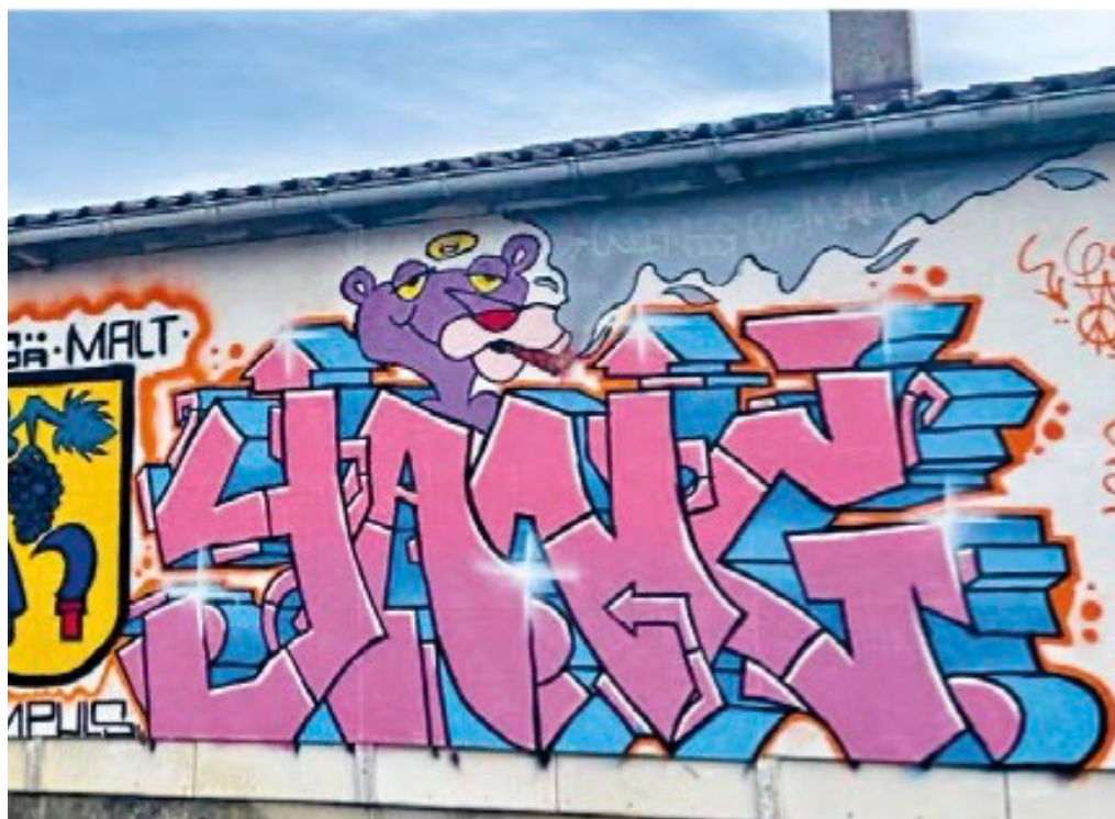
Sprayerwand beim Jugendraum
